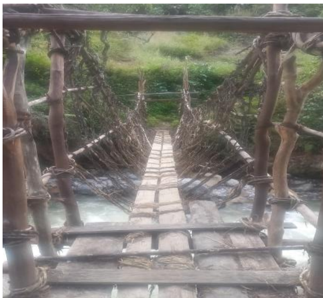
Gambar: 30 Jembatan Gantung ( Yadu Kele Paga )
