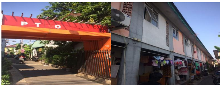
Gambar 4.4 Gapura Rumah Deret Potogongan dan Kondisi Penghuni Rumah Deret Jakarta
